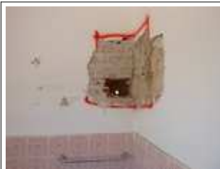
Piano terra: Muratura in tufo con cavedio.
