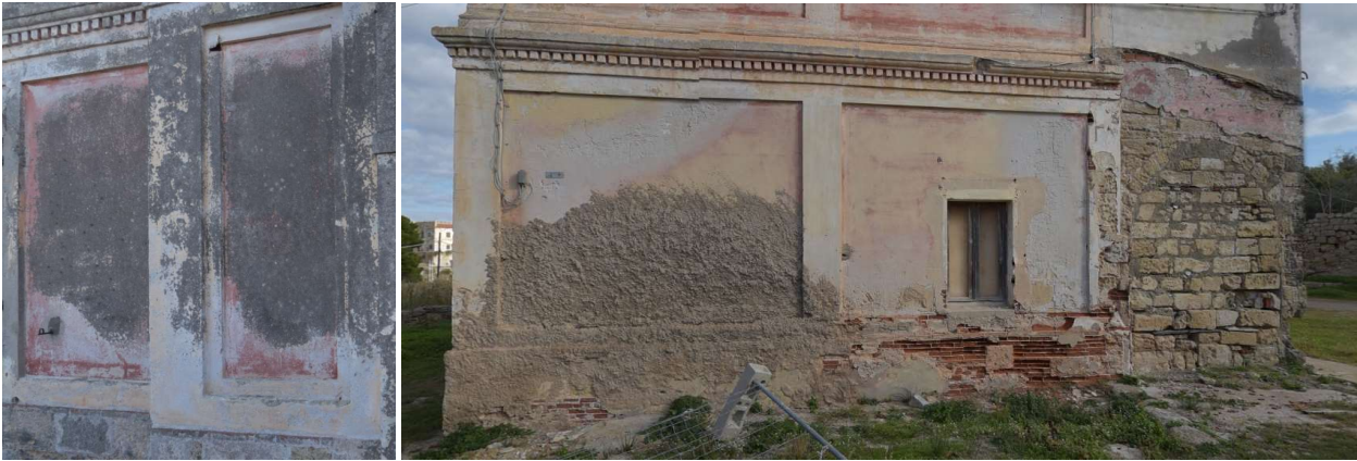
Figura 15 Patine biologiche del prospetto principale esposto a nord; concrezioni e degrado dei laterizi del prospetto ovest
