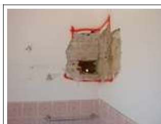
Piano terra: Muratura in tufo con cavedio.
