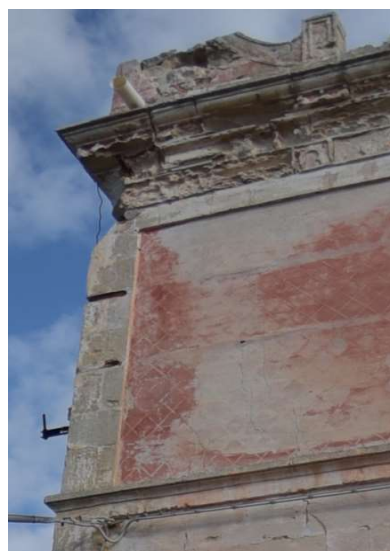
Figura 13 Degrado degli elementi in pietra
