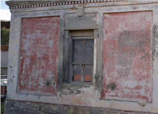
Figura 12 Degrado degli intonaci
