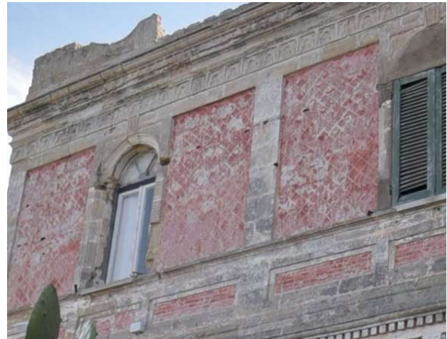
Figura 12 Degrado degli intonaci
